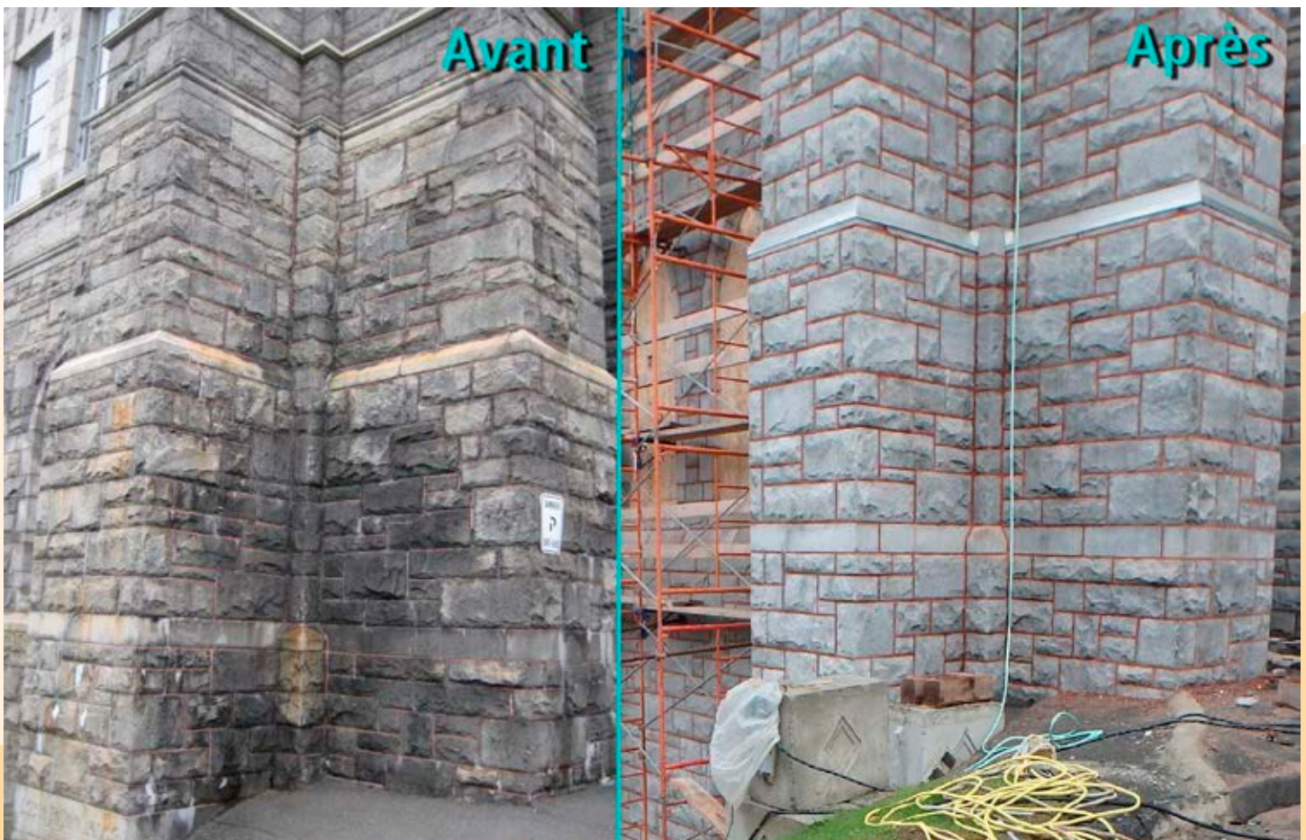
Remplacement du mortier et nettoyage du granit et pose de solins métalliques
